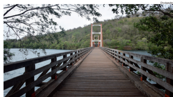
Inaugurada em 1920, a histórica Ponte Alves de Lima transpõe o Rio Paranapanema e liga a cidade de Ribeirão Claro, no norte do Paraná, a Chavantes, em São Paulo. Com 149 metros de extensão e vão suspenso de 82 metros, a ponte em madeira é exclusiva para travessia de pedestres e foi tombada como bem cultural de interesse histórico e tecnológico pelo Governo do Estado de São Paulo em 1985 e pelo Conselho Estadual do Patrimônio Histórico do Paraná em 2001.
